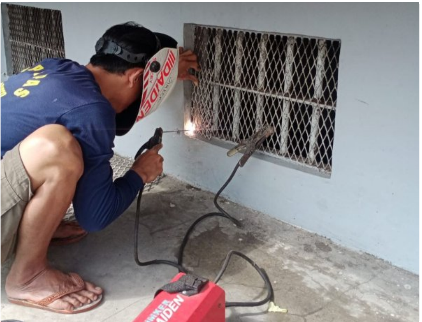
Lapas Kelas IIA Purwokerto Lakukan Rehabilitasi Bangunan
